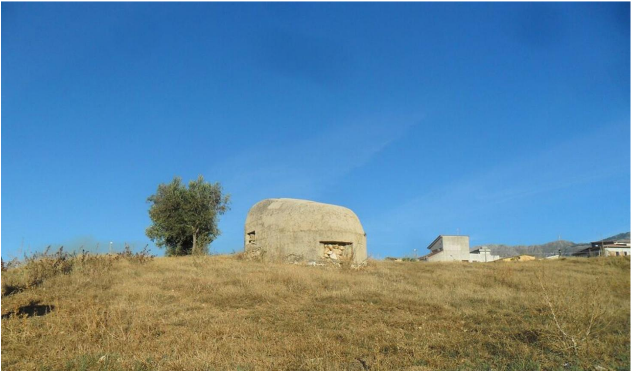
Fig.3. Avamposto monoblocco in cls a difesa della SP 63, Partinico.
