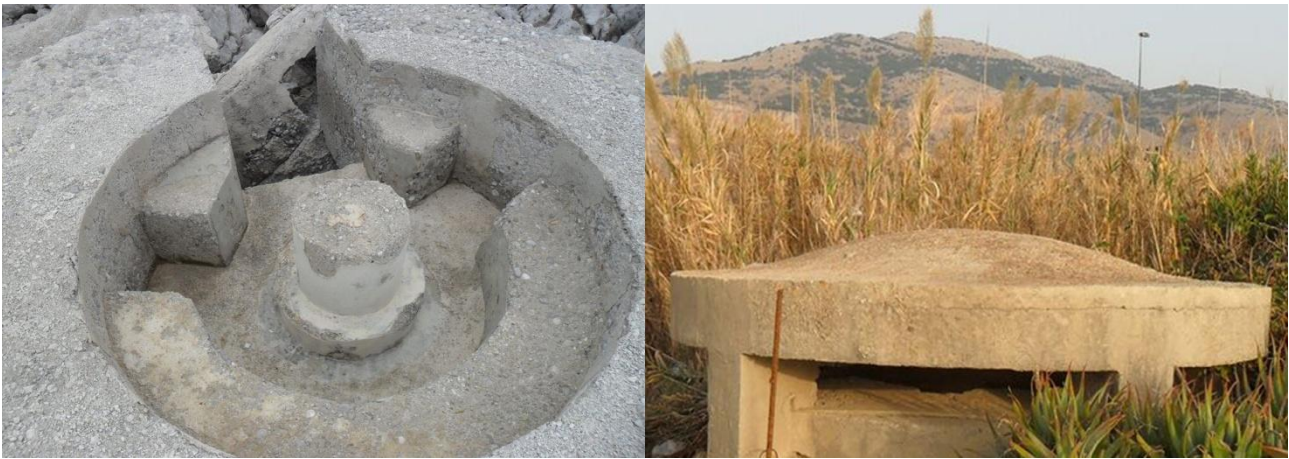
Fig.7. Dettagli dei sedili e della copertura a volta, Isola delle Femmine e Carini.
